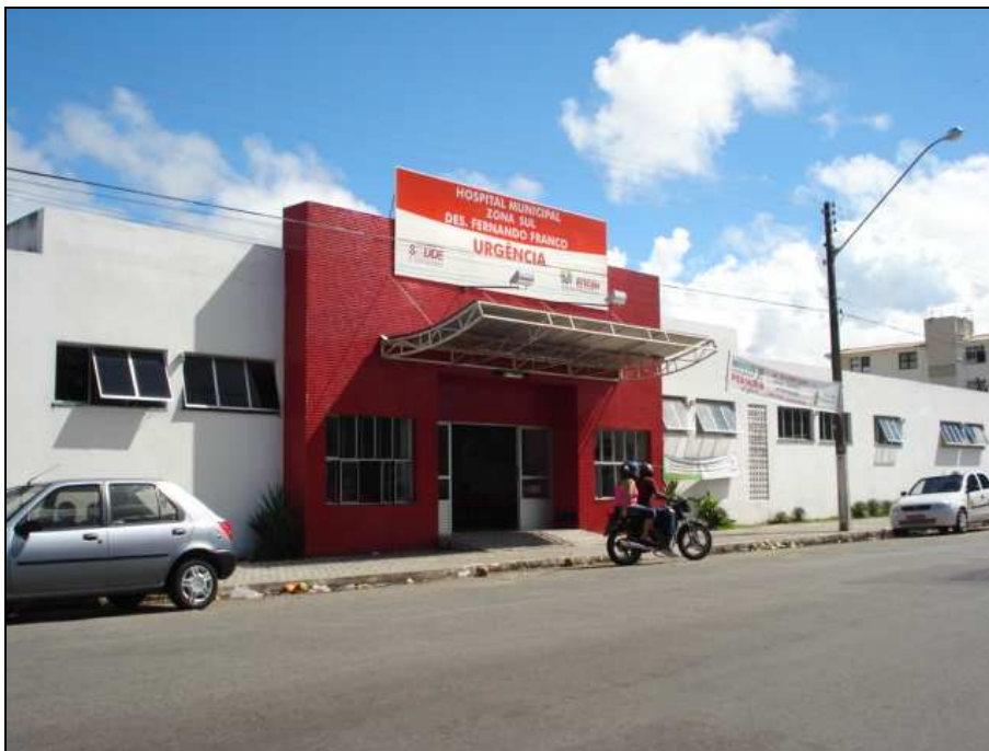
Figura 40 - Unidade Hospitalar Fonte: Trabalho de Campo, 2008
