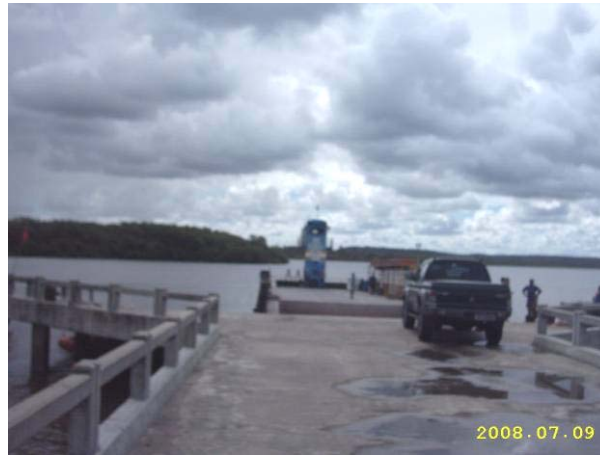
Foto 34 – Trapiche da balsa, utilizada para travessia do rio Piauí, Povoado de Terra Caída. AID do empreendimento.
